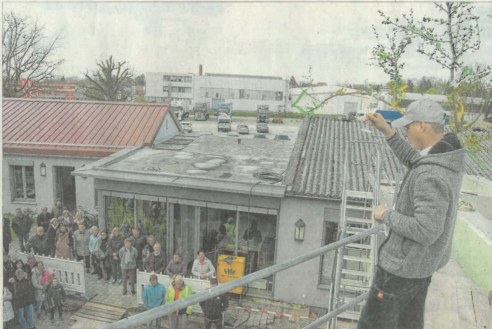
Auf dem Dach des neuen Gebäudes erhob Zimmermeister Lukas Riedel das Glas und dankte beim Richtfest allen am Bau Beteiligten für das gelungene Werk. Die Kosten des Projekts bezifferte der Evangelische Krankenpflegeverein auf rund 1,4 Millionen Euro. Foto: Markus Weinzierl
